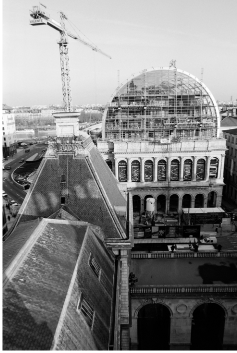
↑ Construction du dôme. Bibliothèque municipale de Lyon © Marcos Quinones
