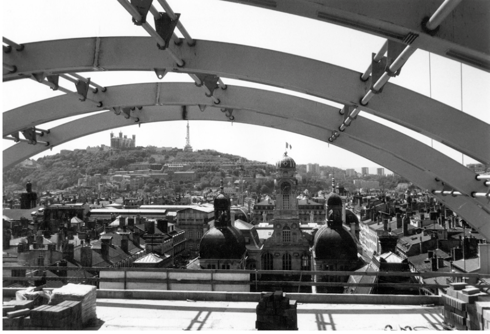
↑ Construction du dôme. Bibliothèque municipale de Lyon © Marcos Quinones
