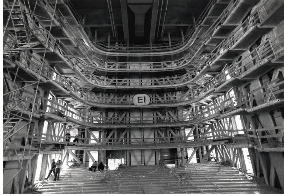
↓ Salle de l'Opéra en travaux. Bibliothèque municipale de Lyon © Marcos Quinones
